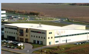
Site Usinage GOSSELIES
