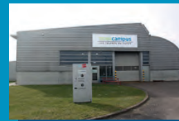
Strépy Quai du Pont Canal 5 7110 Strépy 064/700 682
